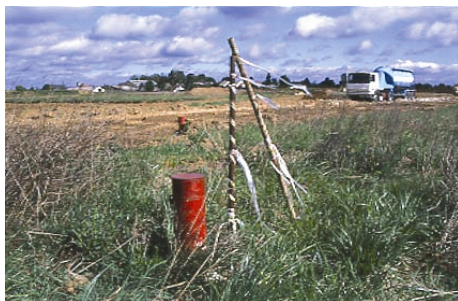
Marquage d'un repère qui sera le centre de l'anneau synchrotron
