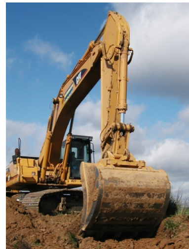
Premier coup de pelleuse le 22 avril 2003
